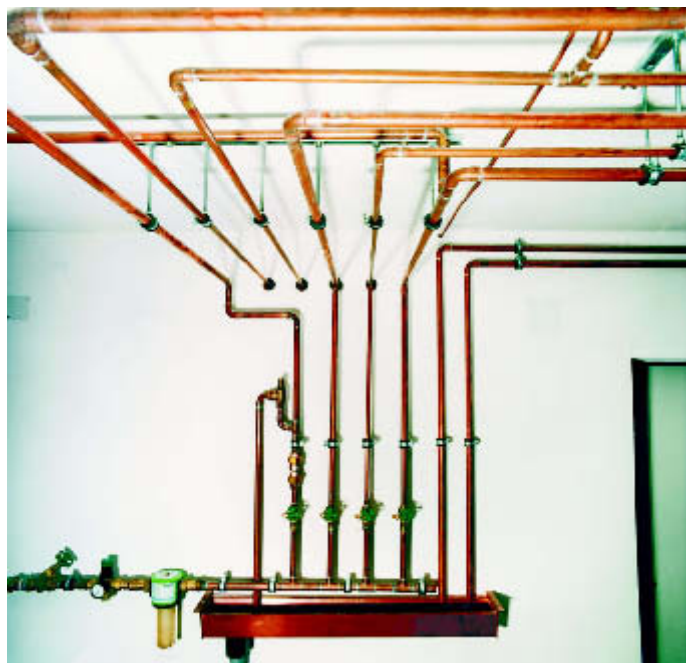
■ Die Erfahrung der vergangenen Jahre zeigt, dass blankes Kupferrohr in rund 95 % der deutschen Trinkwässer einsetzbar ist. Innenverzinnete Kupferrohre dürfen im gesamten Bundesgebiet und bei allen Wasserqualitäten eingesetzt werden.
